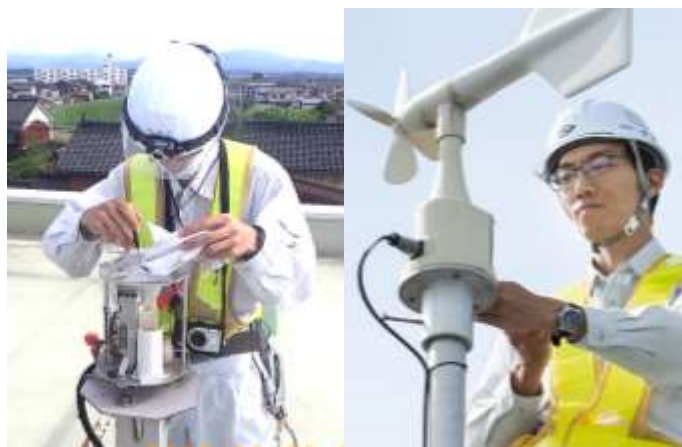
観測施設・点検スタッフ
